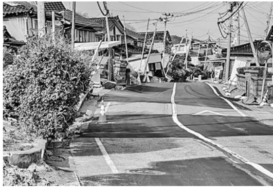
内灘地区・大きく歪んだ地面と家々
